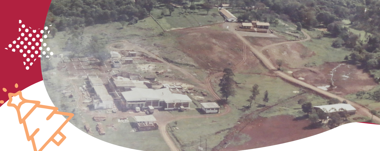
Imagen aérea de la primera planta de Cofra en Alem.
